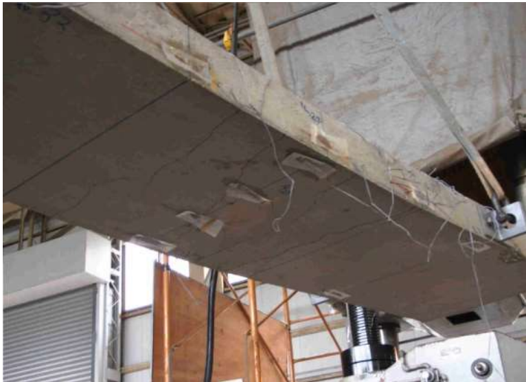
載荷試験後のひび割れ状況
